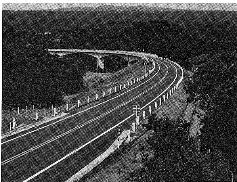
写真5 能登大橋一橋長430m高橋脚を有する4径間連続PCラーメン箱桁橋
