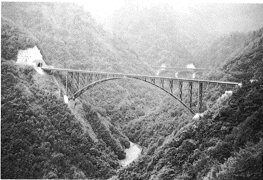
「平成の140号」-埼玉県施工の橋梁雁坂トンネルに係るアプローチ部分
