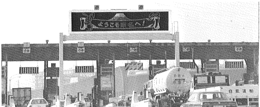
写真8 料金所情報板(LED式)
