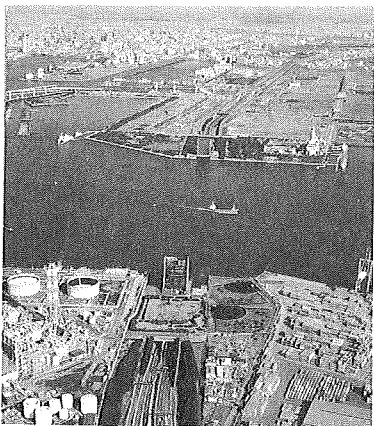
写真1 東京港トンネル
