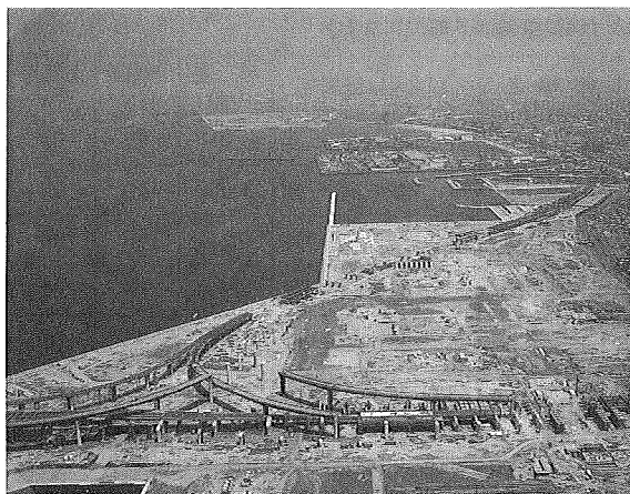
前島付近の大阪湾岸道路建設現場
