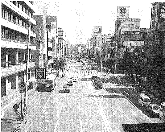
市道中央通り線施工前
