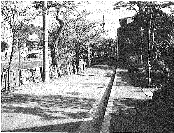
写真3 地中化施工前
