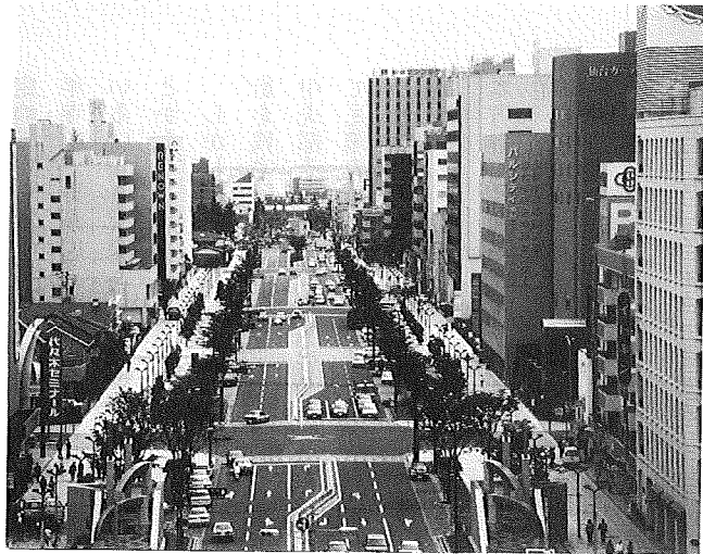
無電柱化された宮城野通り
