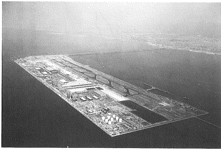
写真1 上空から見た関西国際空港の現況写真
