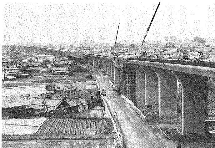
写真 2 急ピッチで工事が進む空港連絡道路
