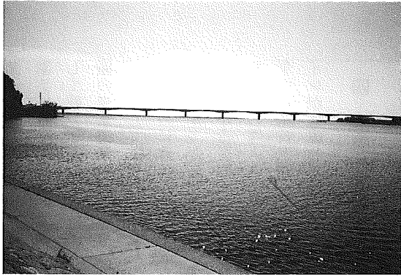
仁淀川河口大橋
