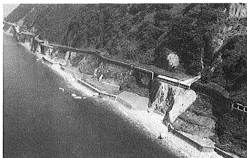
防災工が施された三代道路
