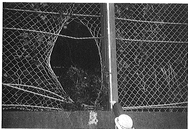
落石により突き破られ、穴があいた落石防護ネット
