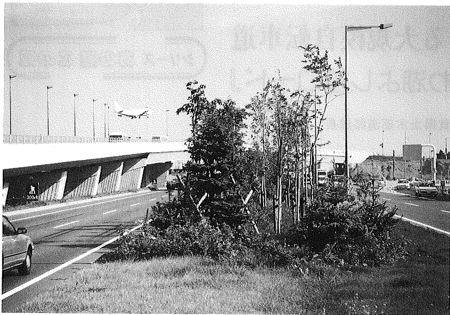
写真 6 36号から空港へ的高架橋
