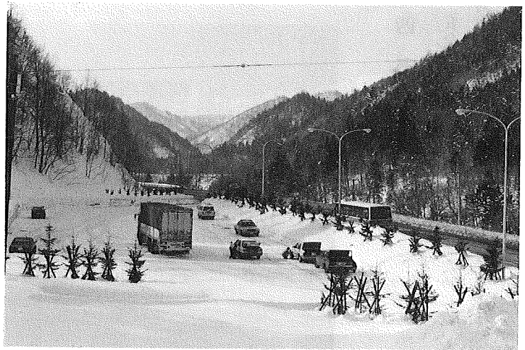
写真6 一般国道230号札幌市薄別チェーン着脱場
