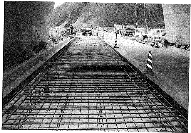
写真3 施設設置状況
