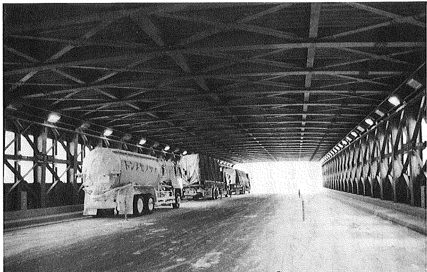
写真7 一般国道40号開源パーキングシェルター
