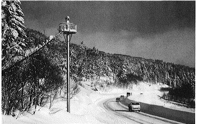
写真4 監視用テレビカメラ
