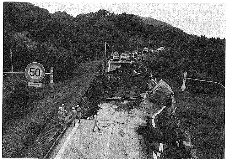
写真2 一般国道5号長万部町知来盛土崩壊
