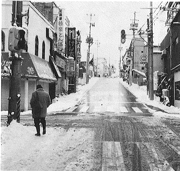
坂道で威力を発揮したロードヒーティング
