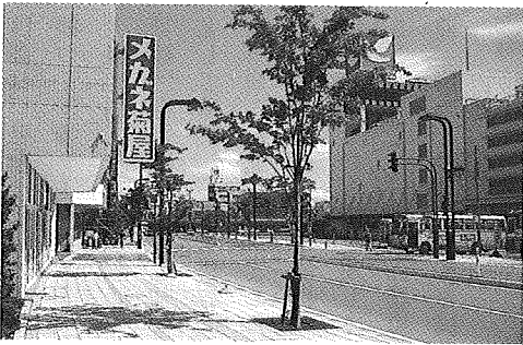
セットバックした沿道建築物
