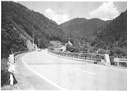
国道311号 中辺路町福定上流より
