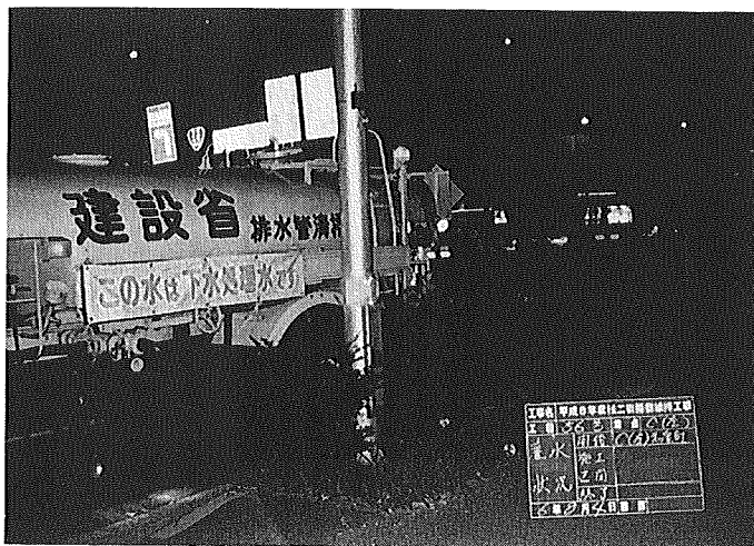
下水道処理水を利用した道路維持管理（灌水）状況
