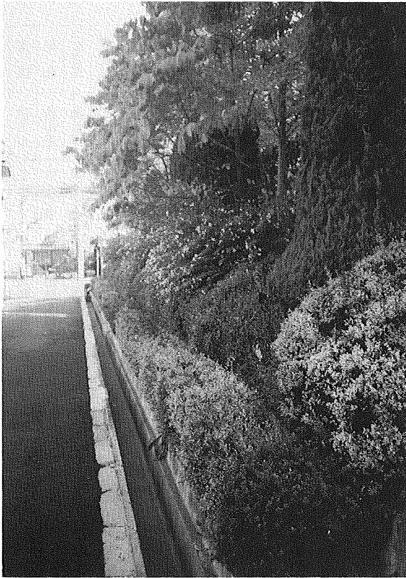
写真2 ツツジ・ツゲ等の枯損状況
