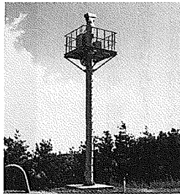
道路を常時監視している ITVカメラ
