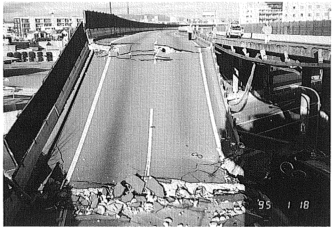
写真1 名神高速道路 瓦木西高架橋（上り）
