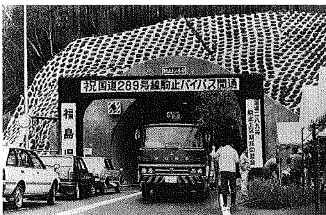
待望の駒止トンネルの開通 （昭和57年11月12日）
