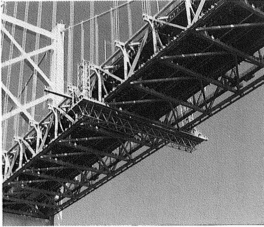
桁外面作業車を使用した補剛トラスの点検
