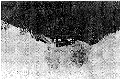
旧国道289号駒止峠の除雪状況（昭和40年代）
