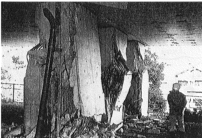
写真2 中国自動車道 宝塚高架橋
