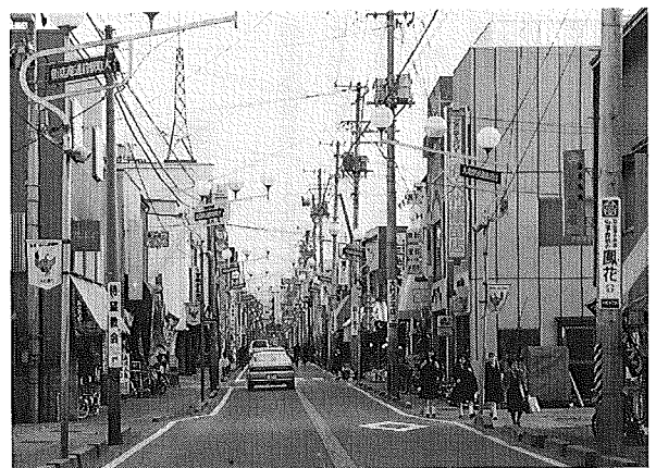
写真3 景観整備の要望の強い会津若松市内（国道118号）
