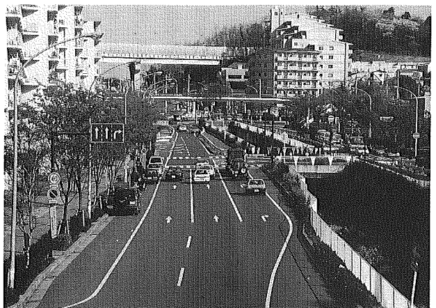
写真10 環状2号線上永谷地区（写真9の反対側）
