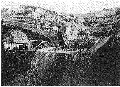
工事中の四国新道
