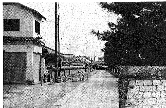
写真3 斑鳩町法隆寺での工事写真（上） ハンドホールの蓋の石張り（右）
