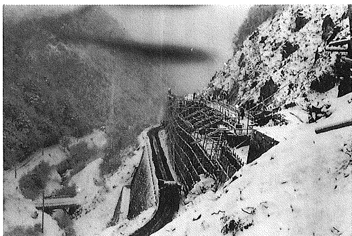
工事中の猪ノ鼻峠
