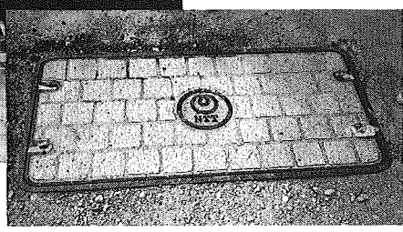
写真3 斑鳩町法隆寺での工事写真（上） ハンドホールの蓋の石張り（右）
