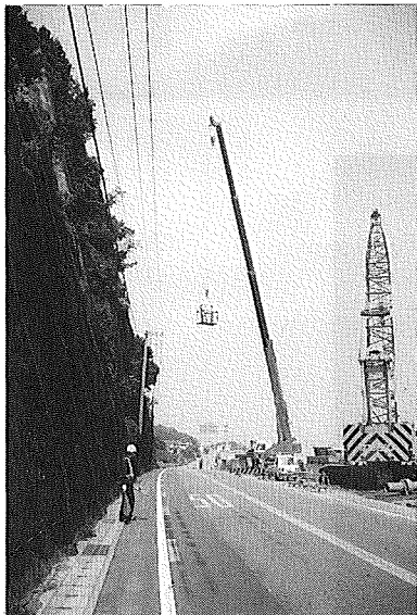
写真5 四国地方建設局の危険箇所点検
