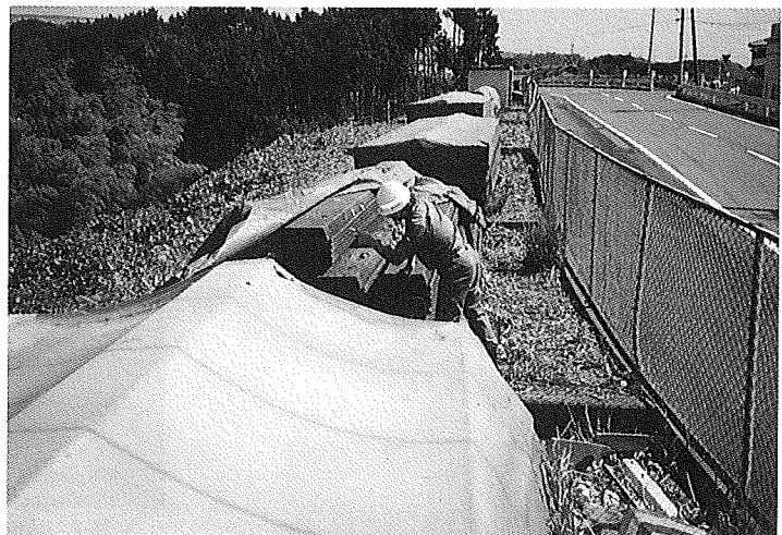
写真8 静岡県の復旧資機材等備蓄状況
