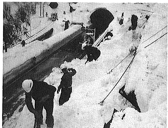
危険箇所の雪底処理
