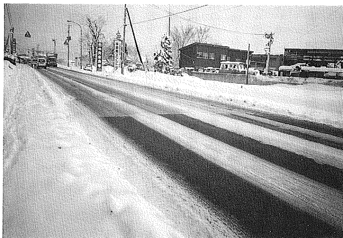
手前が凍結抑制舗装、奥が一般舗装
