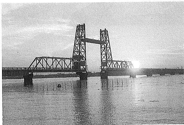
筑後川昇開橋
