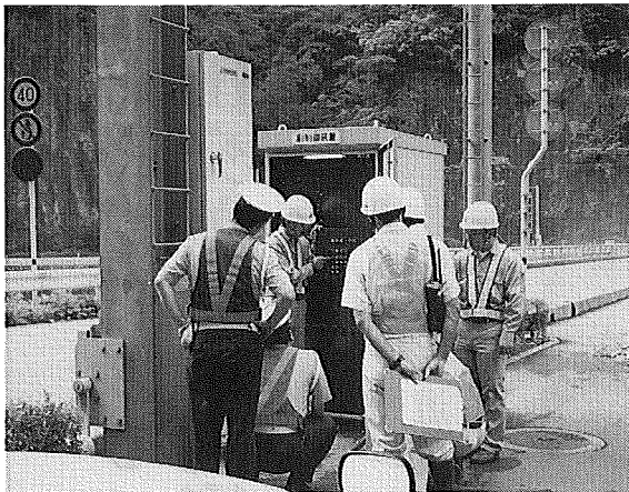
写真7 トンネル情報提供施設点検(三重県)
