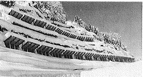
雪崩予防柵設置状況
