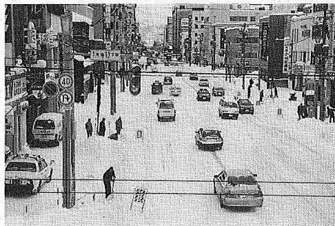
写真6 旭川市一条流雪溝投雪状況
