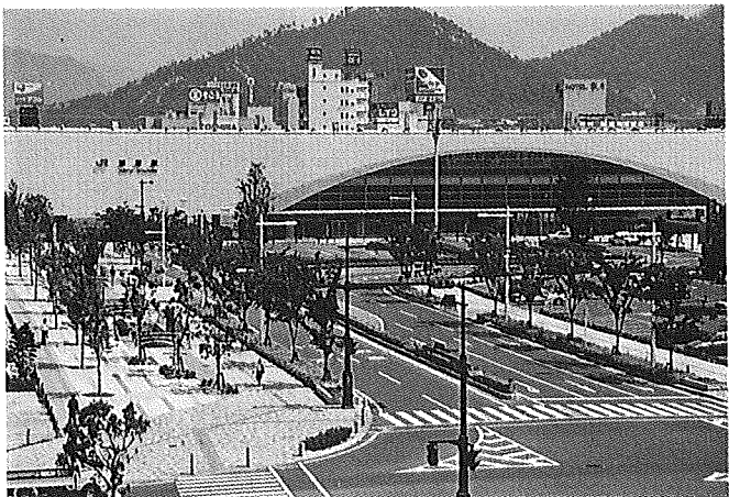
防府駅北地区区画整理事業(防府市)
