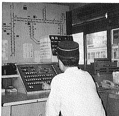
写真1 広島電鉄(株)の電車接近表示器(上)と路面電車運行状況表示装置(電車ロケーション)(右)
