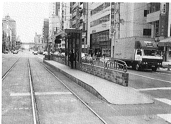
写真2 スロープ、上屋、柵、電車接近表示器を設備した電停
