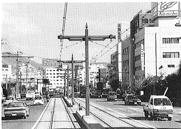
写真9 長崎電気軌道株のセンターポール
