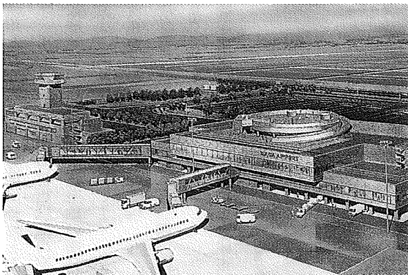
平成10年7月開港の佐賀空港
