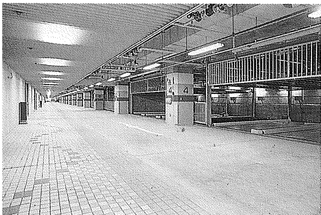
車路進行方向の右側が車室、左側が歩道部
