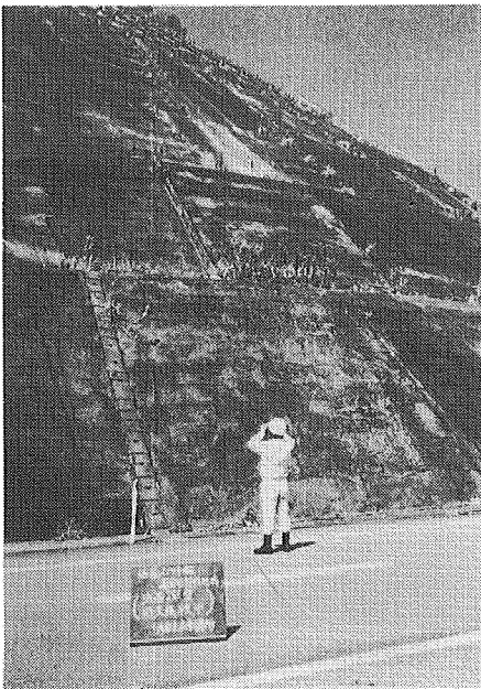
写真8 法面の点検（熊本県）
