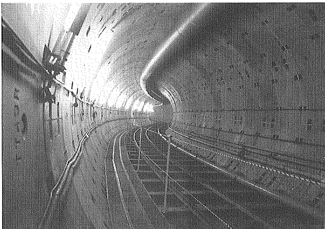
一次覆工完了後の共同溝
