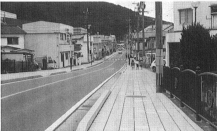
国道384号 上五島町青方（平成8年完成）
