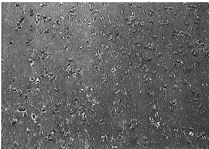
写真2 ゴムロード舗装の表面
