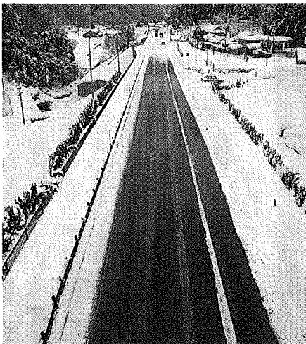
写真3 無散水融雪による路面状況
