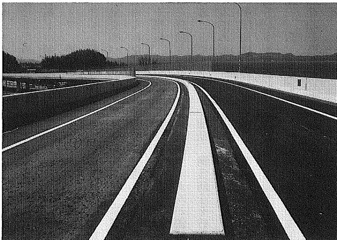
写真1 左がゴムロード舗装
