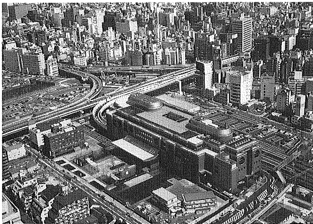
写真6 湊町出路（南側出路）
