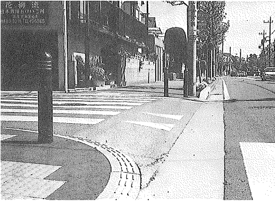
写真9 スムース歩道 (連続歩道式)
