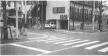
写真7 スムース歩道 (連続歩道式)
