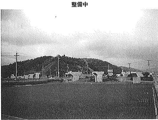
主要地方道 坂本高浜線 子生踏切
