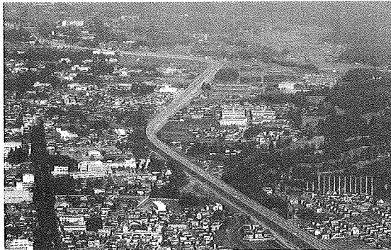
写真3 国道119号宇都宮北道路
