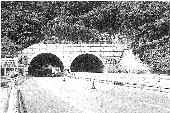
写真2 喜舎場トンネル坑口修景
