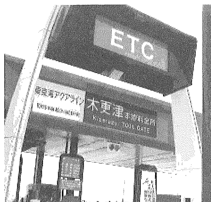
写真1 ETC車線表示板
