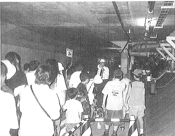
海ほたるパーキングエリアにて・避難用地下通路と救出口を見学
