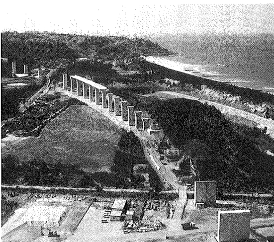
国道9号青谷・羽合道路（山陰自動車道関連事業） 泊ICから泊高架橋を望む
