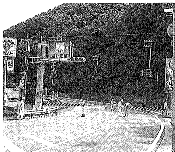
国道26号 交通遮断機点検 日高郡日高町～有田郡広川町 「確認よし！」
