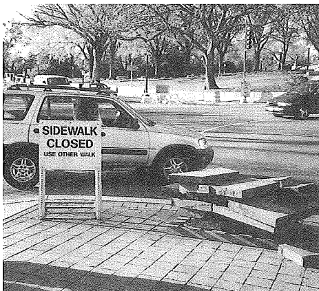
ワシントンD.C. ホワイトハウス近くで行われていた舗装工事
