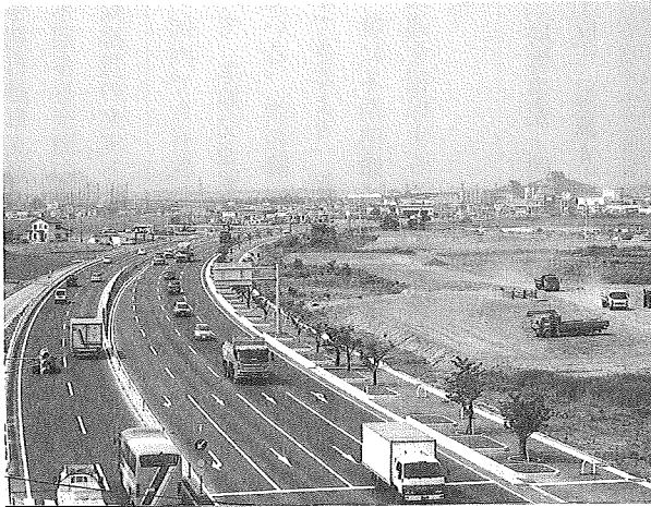
写真2 地域高規格道路 国道102号弘前尾上道路
