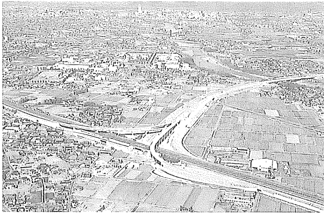
北関東自動車道 高崎ジャンクション付近 (建設中)
