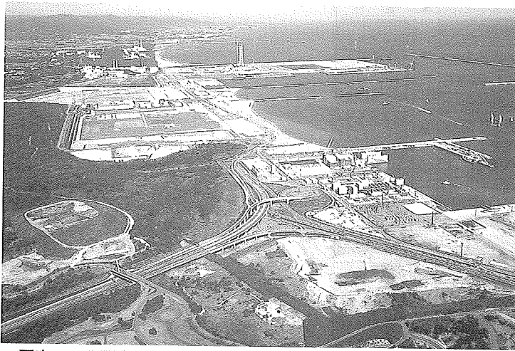
写真2 北関東自動車道等によって常磐自動車道と結ばれた常陸那珂港
