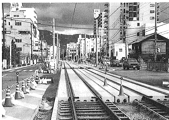
写真4 南町～道後温泉間 軌道移設工事
