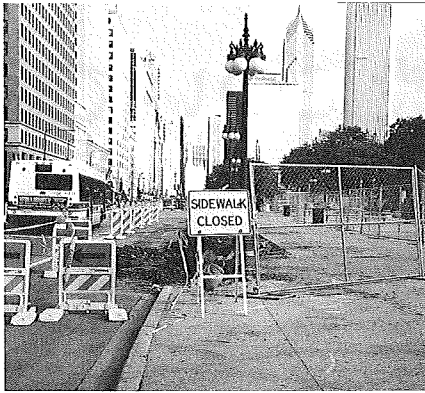
シカゴ市道路工事
