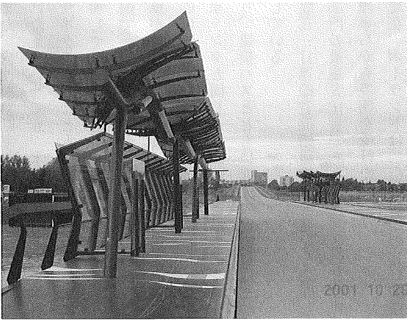
写真2 バス専用道路ザウトヘント
