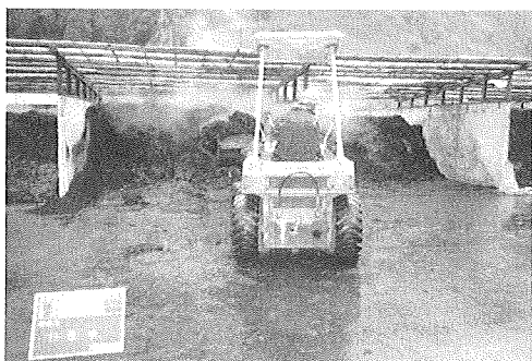
写真6 切返し作業状況
