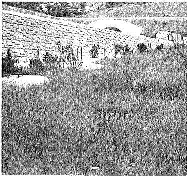
写真5 盛土部を擁壁化し湿地を保全
