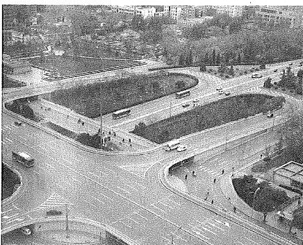
写真1 北京市内の立体交差 下が2環路。上の道路は天安門の前を通り中心部を東西に貫通する北京市のメイン道路。副道の立体交差部は高さ制限2.5mで小型車専用。
