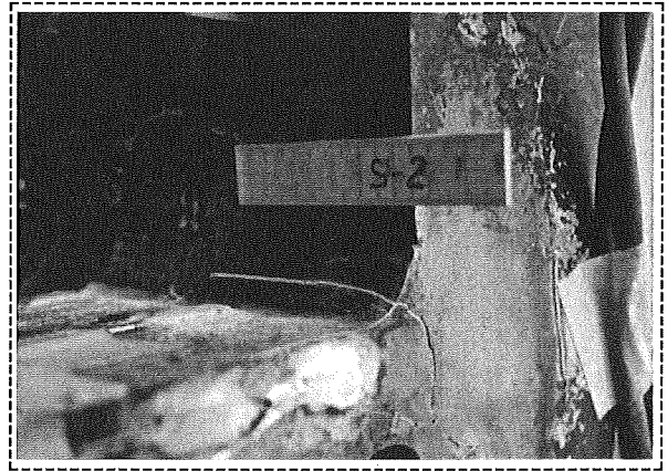
写真1 鋼製橋脚隅角部の疲労損傷
