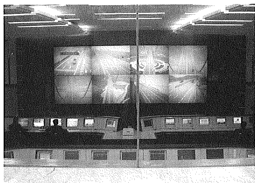
写真5 江陰長江公路大橋管理施設内部の様子
