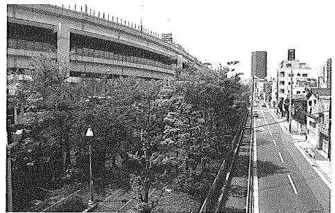
写真5 深川付近環境施設帯（9号深川線）
