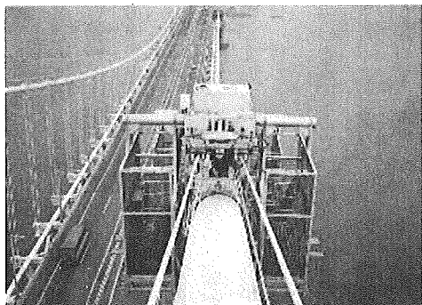
写真2 ケーブル作業車
