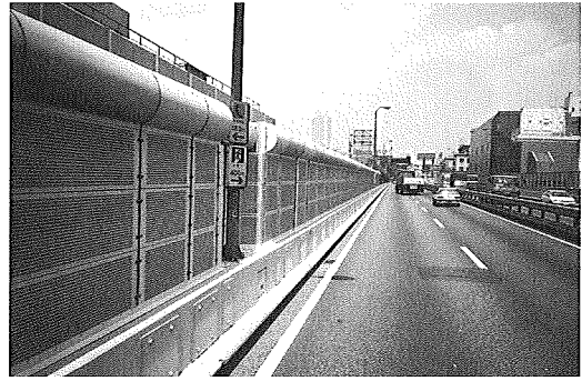
写真1 新型遮音壁（5号池袋線）
