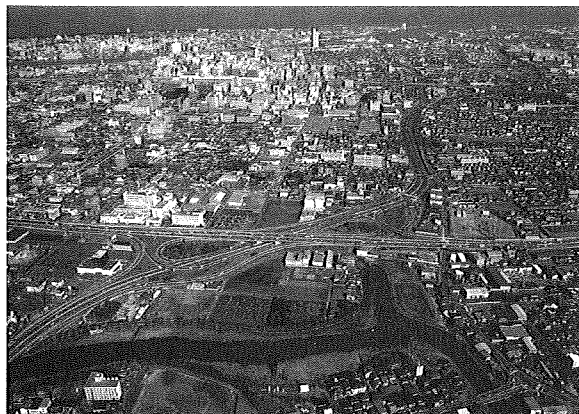
写真2 インターチェンジ方式の新潟バイパス
