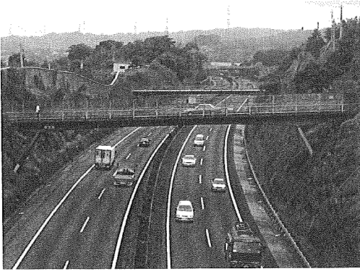
東名高速道路とこ道橋（静岡県富士市内）
