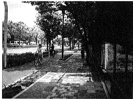
写真1 植栽帯による自転車・歩行者空間の分離（愛知県名古屋市）
