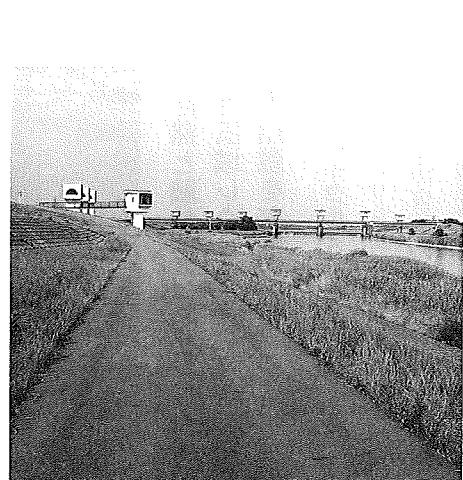
写真6 サイクリングコース整備後
