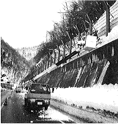
写真3 雪崩防止柵の除雪作業
