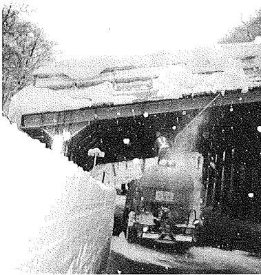
写真5 スノーシェッドの除雪状況
