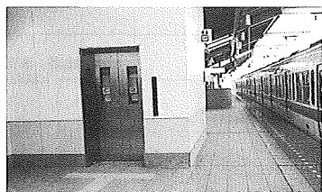
エレベーター
