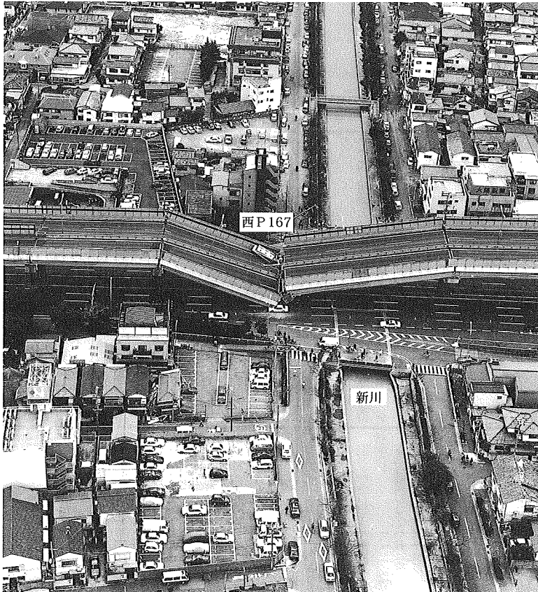
本件橋脚（西P167橋脚）の倒壊現場写真
