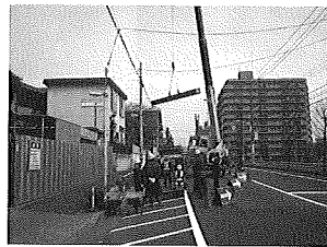
自転車走行レーンの設置工事
