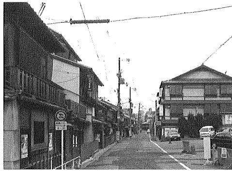
写真1 整備前 電線や電柱が洗練された花見小路のまちなみ 景観を阻害していました。
