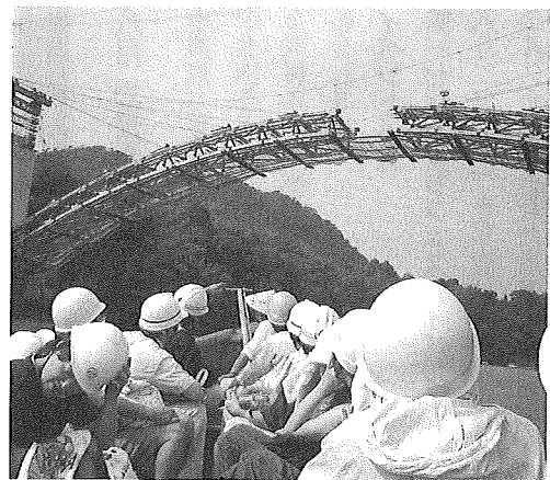
写真3 船上よりアーチ橋架設見学
