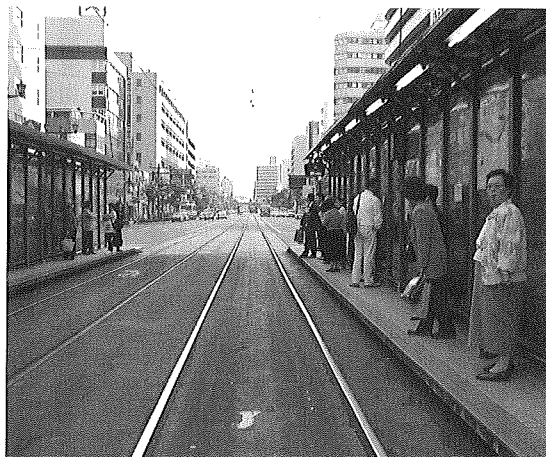
写真1 道路上に設置されている停留場
