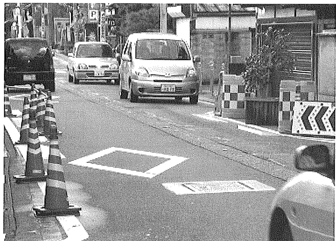
写真7 片側シケインから両側からの狭さくタイプに変更
