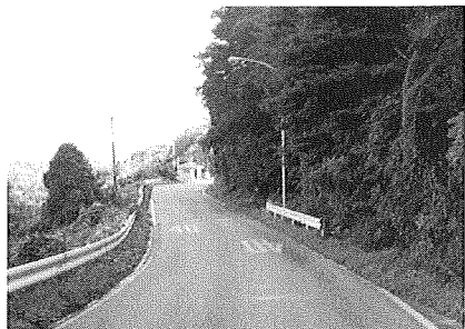
写真4 整備前の状況 (幅員が狭く、すれ違いが困難)
