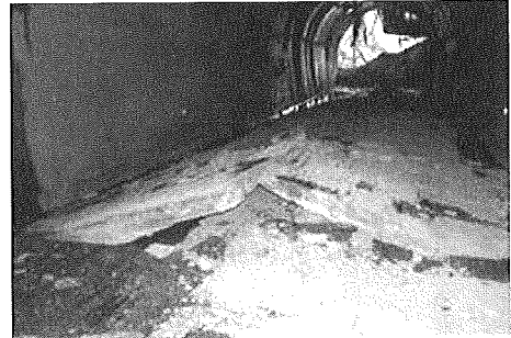
写真4 被害を受けた羽黒トンネル
