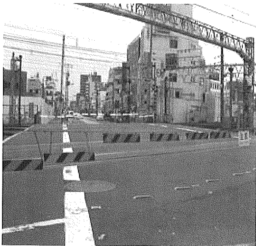
写真3 竹ノ塚踏切事故現場
