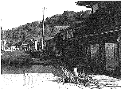
写真1 泥流に襲われた集落 (国道291号 小千谷市)
