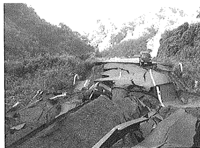
写真3 道路の崩壊 (国道252号 魚沼市)
