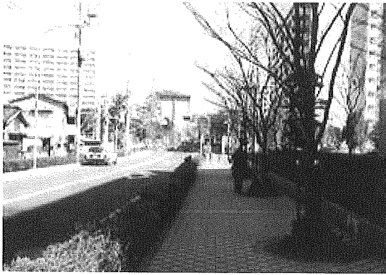
写真2 相模鉄道本線連続立体交差（現況）
