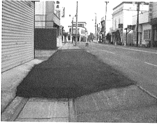
写真1 仮舗装によるフラット体験
