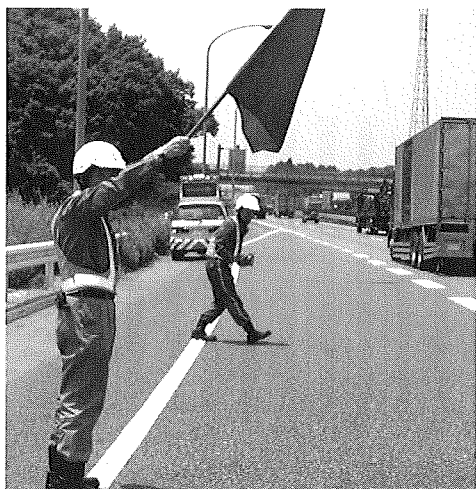
写真2 道路パトロールによる落下物処理状況
