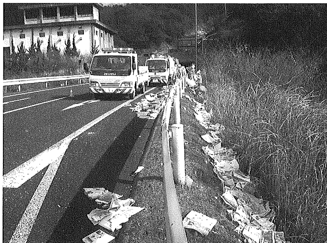
写真3 維持作業による落下物処理状況
