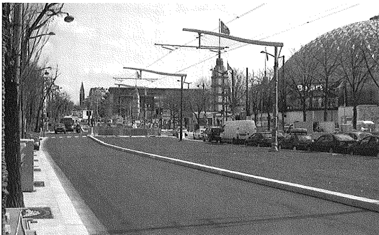
写真1 フランス・パリ市内で初めての路面電車として 建設中のトラム3号線(2006年12月開業予定)
