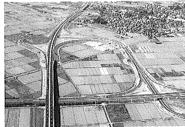
東北横断自動車道酒田線(横)と東北中央自動車道(縦)
