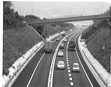
写真4 西九州自動車道唐津道路
