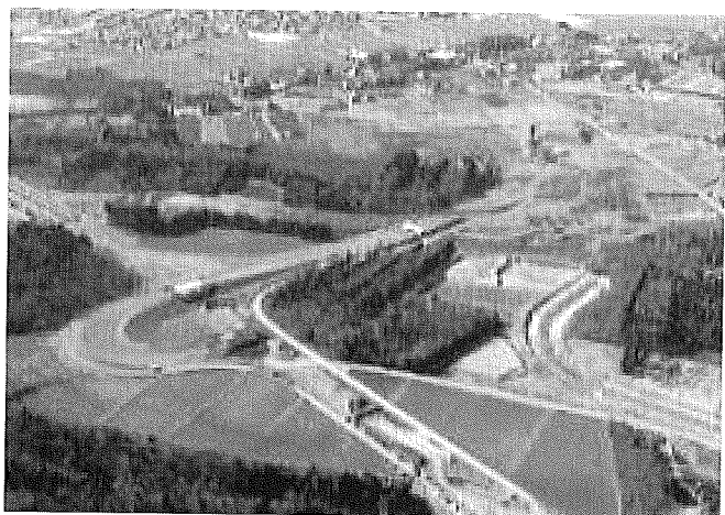
写真6 (仮称)真岡IC付近
