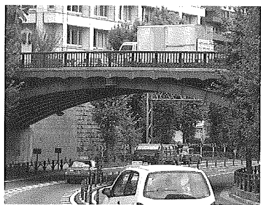
写真2 明治通から見た千登世橋
