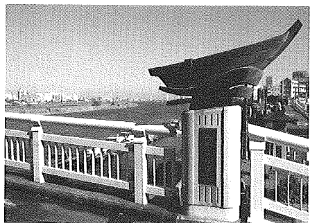
写真2 六郷橋に設置されたモニュメント
