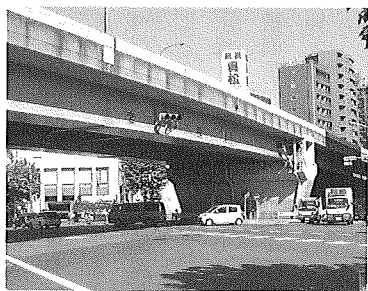
写真4 新三河島の陸橋部
