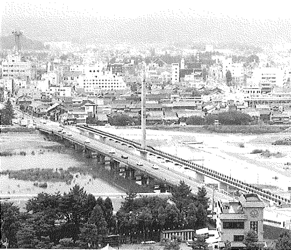
写真7 日野川と斜張橋の万代歩道橋
