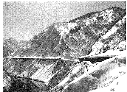
写真3 国道156号のスノーシェッド
