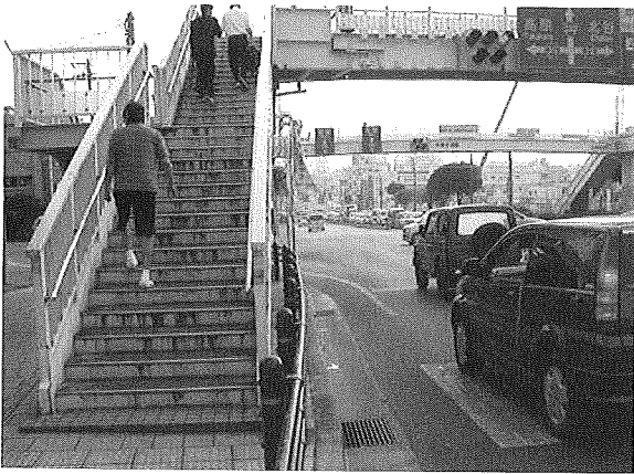
写真2 胡屋横断歩道橋
