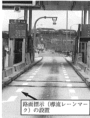
写真5 料金所における路面標示
