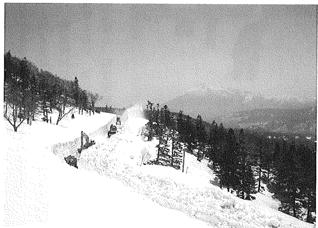
写真11 岩手県の春の訪れを告げる「アスピーテライン」の除雪作業の様子（背景は岩手山）
