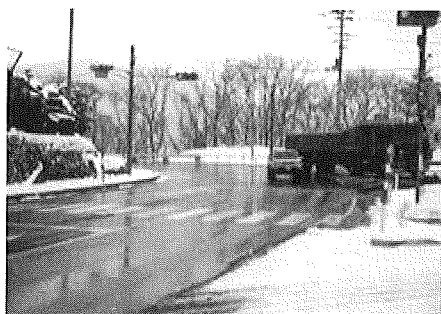
写真6 国道107号交差点部の消融雪
