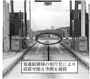
写真4 料金所における開閉バーの短尺化
